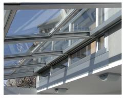
Il tetto scorrevole della ditta E. Biasi aiuta ad evitare un accumulo di calore e garantisce un'ottimale ventilazione. L'apertura può essere fatta dall'alto al basso o viceversa. Con l'installazione di binari a 1, 2 o 3 vie è possibile aprire fino a 2/3 della superficie coperta. La movimentazione del tetto avviene tramite motore elettrico. Profili di finitura, spazzole e le guarnizioni in EPDM sono l'equipaggiamento standard dei nostri tetti scorrevoli.
