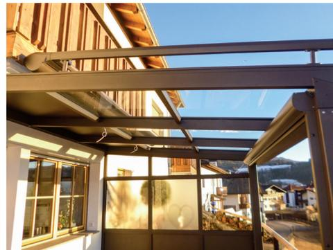
Le nostre strutture a tetto fisso offrono una protezione contro tutte le intemperie. I nostri tetti sono realizzati con profili in alluminio anodizzato o verniciato a polvere. La forma del tetto, la sezione del profilo e la tipologia del vetro sono calcolati e prodotti in base alle dimensioni del sistema e sposando le vostre esigenze e quelle dell'edificio.
