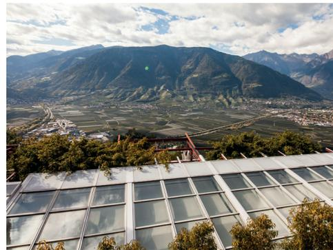
Unsere fixen Dachkonstruktionen werden aus eloxierten oder pulverbeschichteten Aluminiumprofilen gefertigt. Die Form des Daches wird an den Gegebenheiten und Ästhetik des Hauses angepasst. Dabei ist es kein Problem ob Sie ein Schrägdach, Flachdach, Satteldach oder Kuppeldach wünschen.
